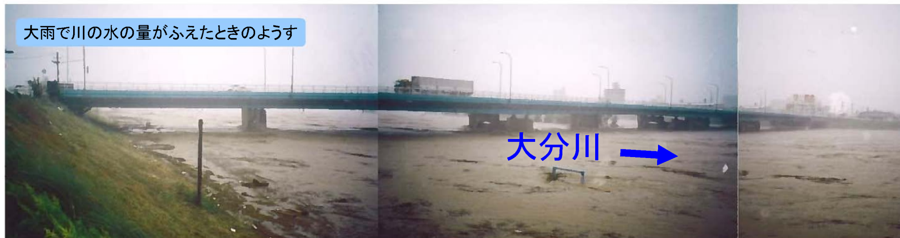
2004年(平成16年)10月20日(台風23号) 大分川 府内大橋付近
