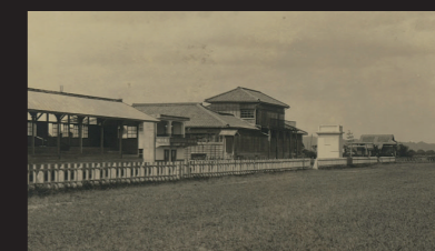
現存する昭和6年開設の一等馬見所(スタンド) 昭和6年に新設されたスタンドが現在も宮崎育成牧場に 姿を残している。当時は芝コースでレースが行われていた。
